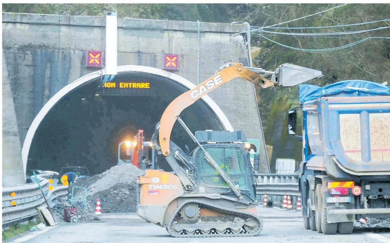
In galleria Procedono i lavori di ispezione e verifica che provocano lunghe code
