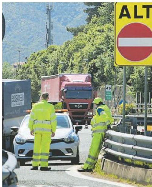
▲ Cantieri permanenti Uno dei numerosi cantieri presenti sulla rete autostradale della Liguria
